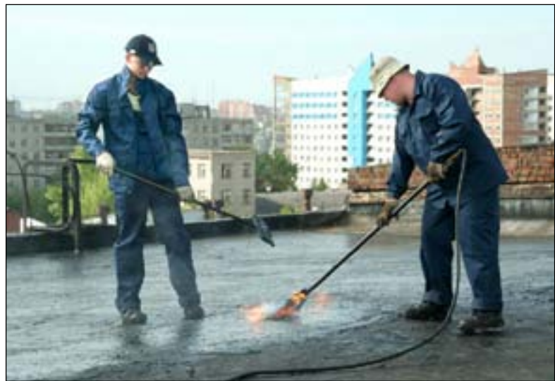
Укладка и выравнивание ВИР-пласта.
